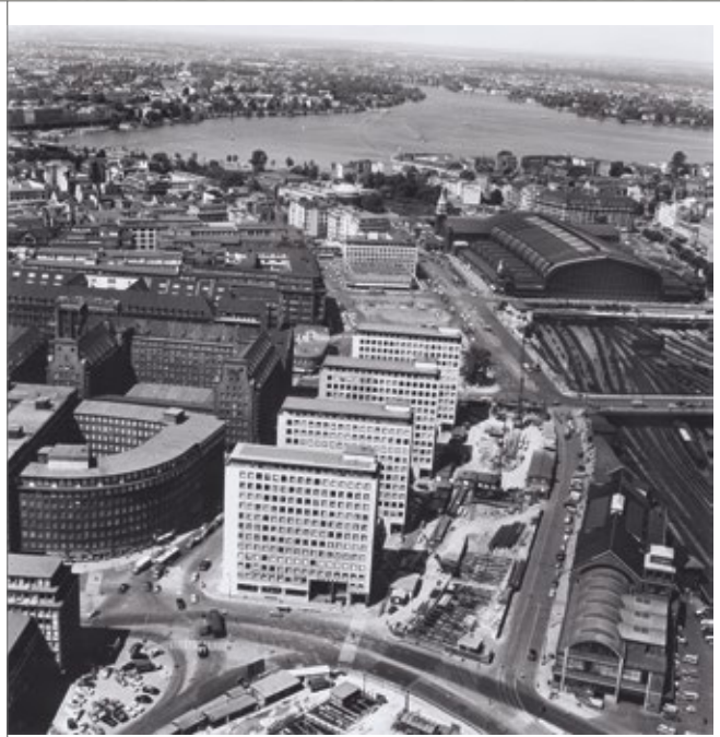
City-Höfe und Wäldertunnel (im Bau) 26.6.1959
